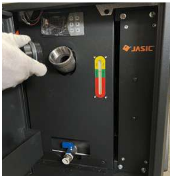
Фото 9.0.3. Заливание охлаждающей жидкости.
