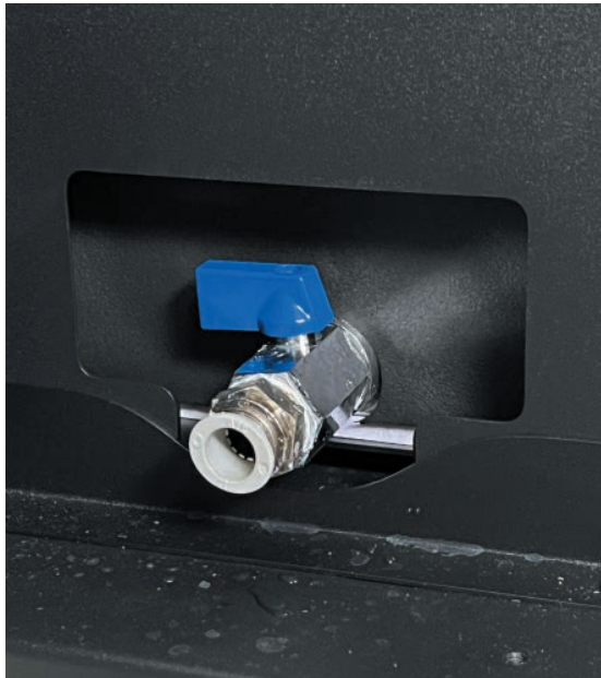
Фото 9.0.4. Слив охлаждающей жидкости.
